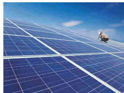
INSTALLAZIONE DI PANNELLI SOLARI IN UN'AZIENDA DELLA CALIFORNIA MERIDIONALE
